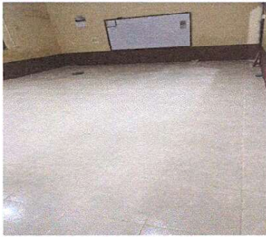
Foto1: Finalizado la instalación de piso dentro del aula
