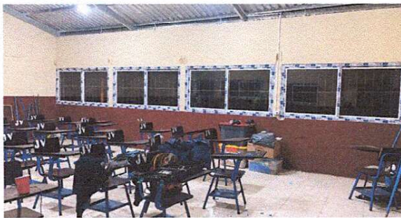
Foto 3: Finalizado la instalación de ventanas dentro del aula
