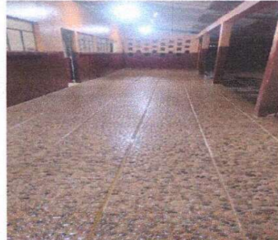
Foto 2: Finalizado la instalación de piso en el corredor de afuera
