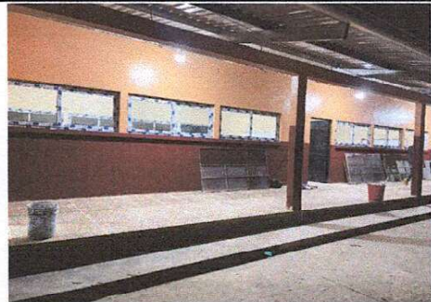
Foto 4: Finalizado la instalación de ventanas fuera del aula
