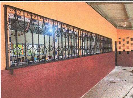
Foto 5: Finalizado la instalación de balcones
